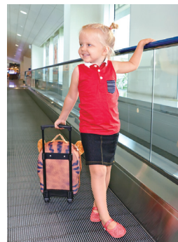
14 moving walkway 電動步道
